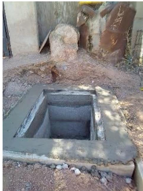
**Logro 12. Construcción del sistema de alcantarillado sanitario (10,776 metros lineales de tubería de PVC sanitario de 8" de diámetro serie 20; 2,401 metros lineales de tubería de PVC sanitario de 6" de diámetro; 343 descargas domiciliarias en la localidad de Santa María de Guaymas en el municipio de Empalme.**
