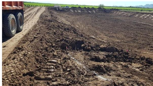
**Logro 17.** Ampliación de los servicios de agua potable que incluye la instalación de 3,538 metros lineales de tubería de PVC de 2" (1,556 metros lineales), 3" (1,377 metros lineales), 4" (605 metros lineales) de diámetro y la instalación de 362 tomas domiciliarias, al sur poniente de la ciudad de Nogales (etapa 1 de 4), en la localidad de Nogales, municipio de Nogales.
