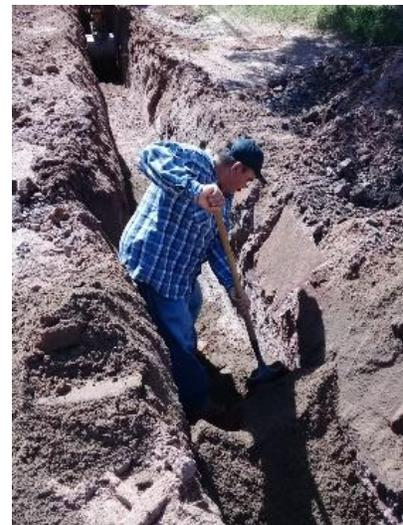
**Logro 11. Ampliación de 3,150 metros lineales de la red de alcantarillado sanitario con tubería de PVC sanitario de 8" de diámetro e instalación de 365 descargas domiciliarias en la colonia Luis Donaldo Colosio en el suroeste de Nogales (etapa 3 de 4) en Nogales, municipio de Nogales.**
