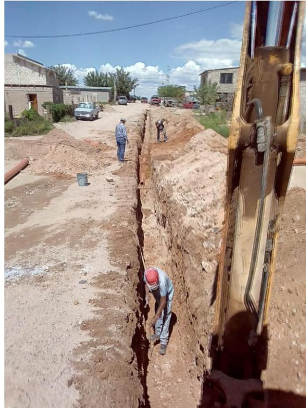
**Logro 10. Ampliación de 5,490 metros de la red de alcantarillado sanitario con tubería de PVC sanitario de 8" de diámetro e instalación de 559 descargas domiciliarias en la colonia Luis Donaldo Colosio en el suroeste de Nogales (etapa 2 de 4), localidad de Nogales, municipio de Nogales.**
