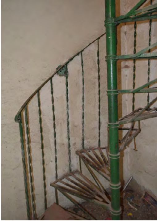
FIGURA 18 Escalera interior. Archivo personal, septiembre de 2019.
