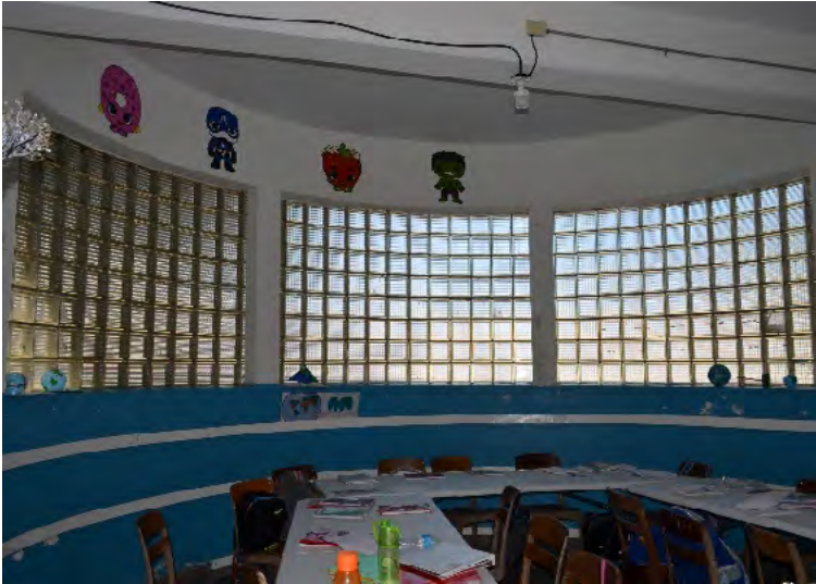
FIGURA 19 Paredes circulares. Archivo personal, septiembre de 2019.
